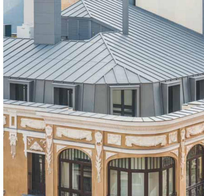
Project: Edificio Tempo Valladolid (Spagna) Client: Blas Recio E Hijos s.l. Photo by Juan Carlos Quindós de la Fuente Architect: Álvaro Finat Urgel
